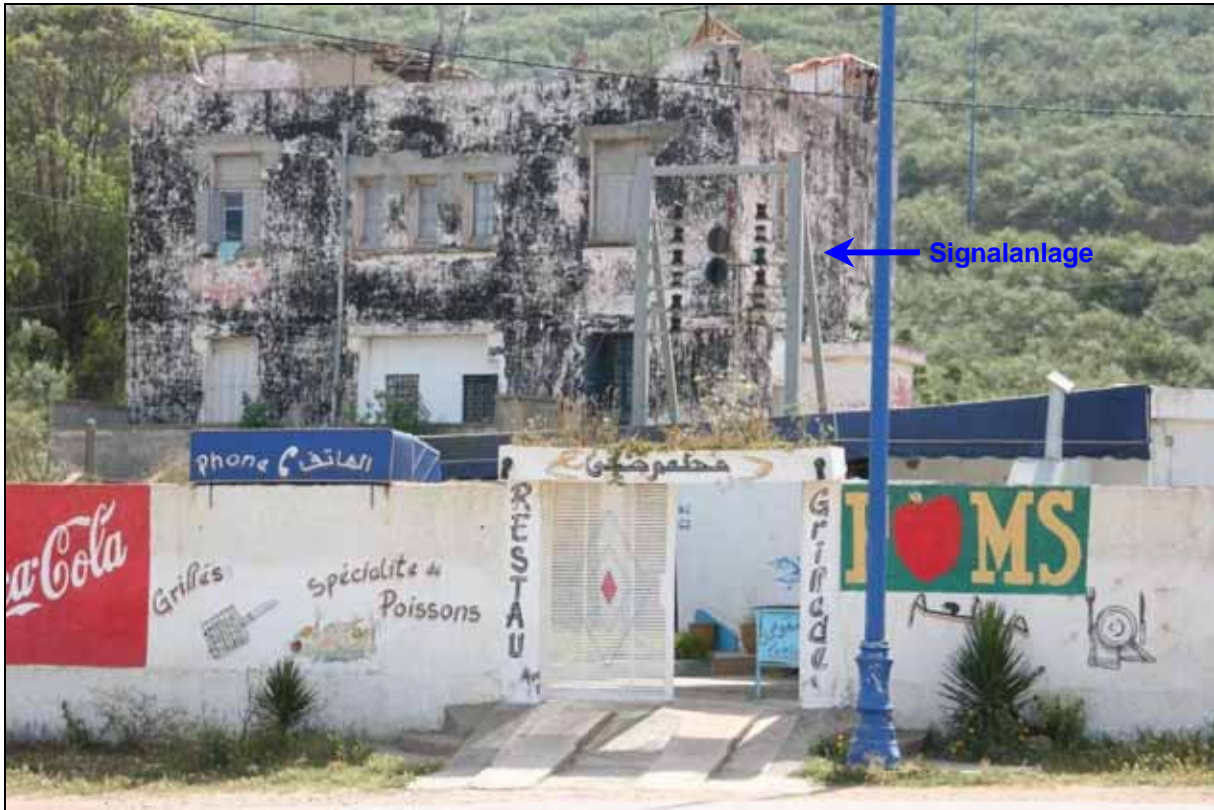
Abbildung 32: Hafensignalanlage, von Nahem aufgenommen
