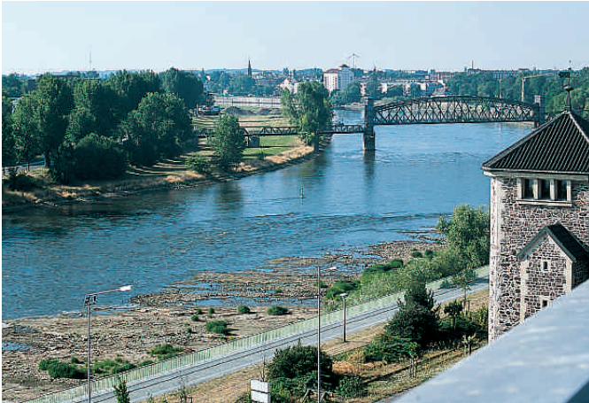
Dass der Magdeburger Domfelsen tatsächlich ein kaptales Schiffahrtshindernis ist, wird bei niedrigem Wasserstand sichtbar.
